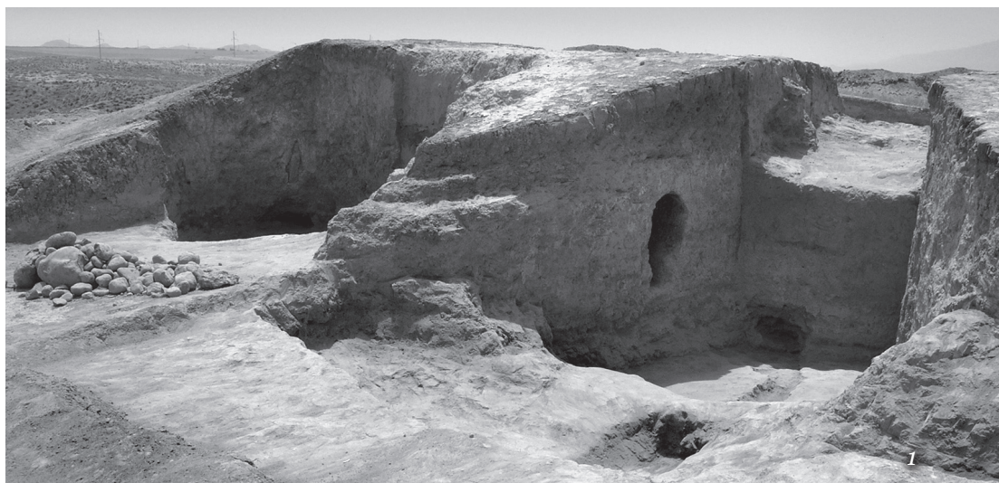
Рис. 35. Вход в крепость Курганзол, внешний фас. Предварительное устройство и канал для подачи воды.
